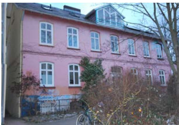
Greves Garten Haus 3, vor der Sanierung
