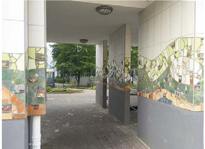
Durchgang Schreyerring (Bild oben und unten)
