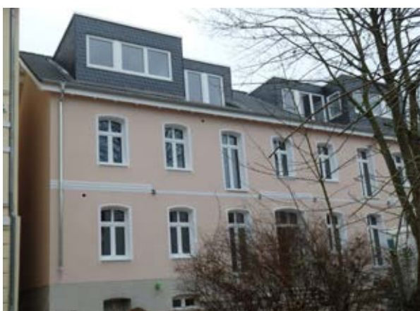
Greves Garten Haus 3, nach Abschluss der Sanierungsarbeiten
